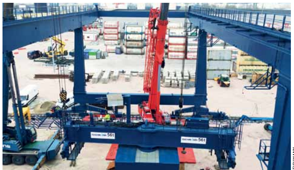
Um einen Transport nach Rotterdam zu ermöglichen, wurden die Brücken in der Mitte getrennt und entsprechende Schweißnähte der Brückenteile in Essen vorbereitet. Die Brückenteile konnten so nach Ankunft im Hafen Rotterdam wieder verschweißt werden.
