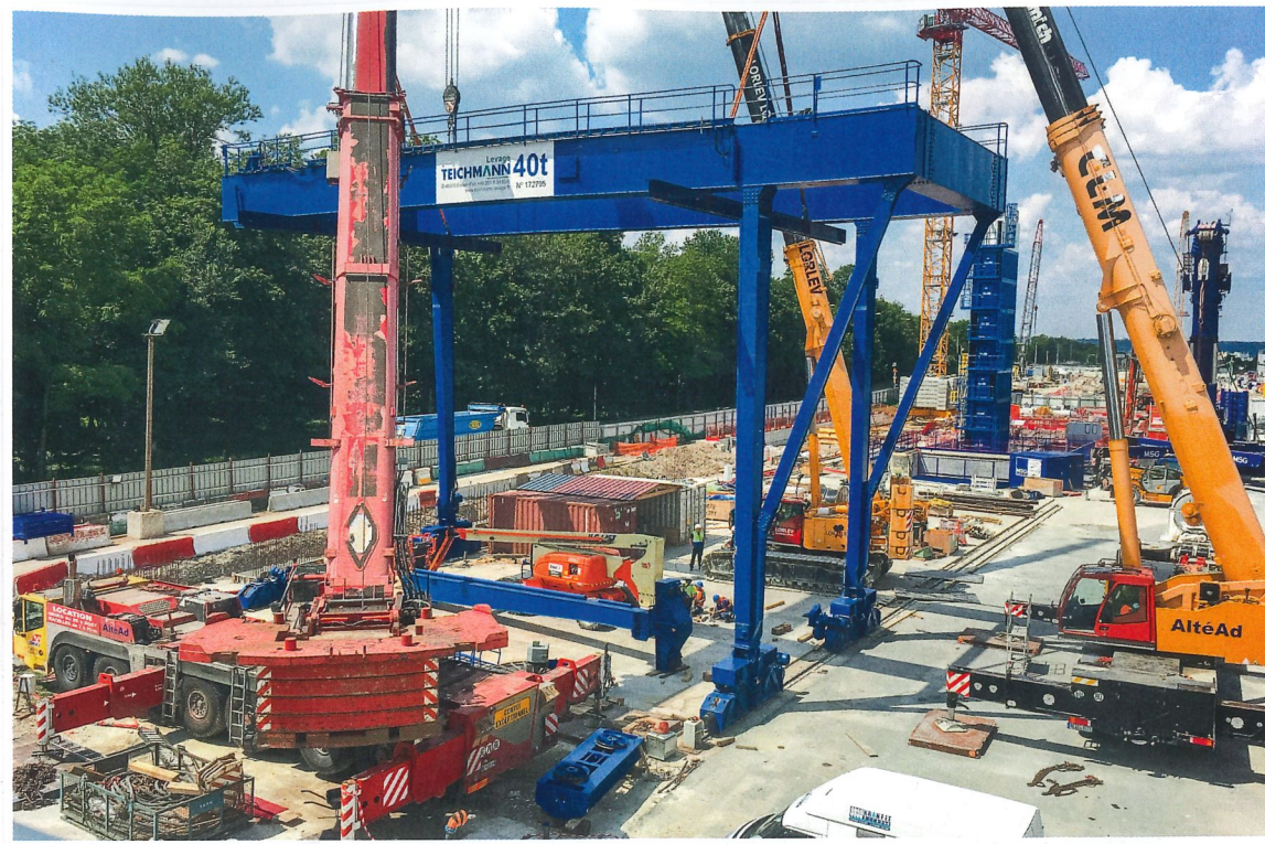
Kran Nr. 2: Ein generalüberholter Zweiträger-Portalkran in Kastenbauweise (40 t x 18,60 m + 2,50 m) wird auf seinen 80 m langen Fahrweg gestellt.
