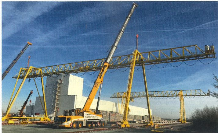
The two, 28 m high sister cranes will operate simultaneously on the storage Auf dem Lagerplatz werden die 28 m hohen Schwester-Krane parallel arbeiten
