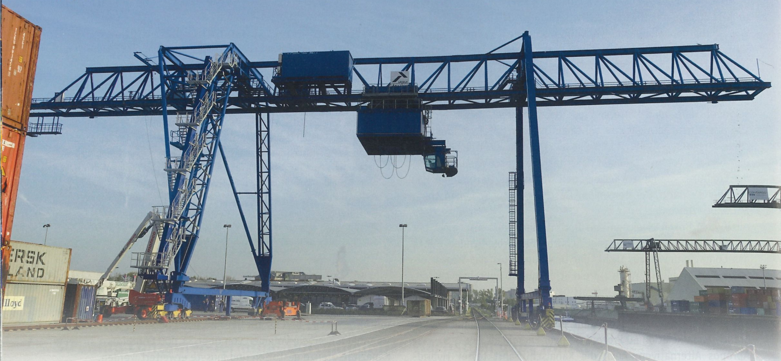
Kran nach Umbau und Modernisierung im Hafen Neuss
