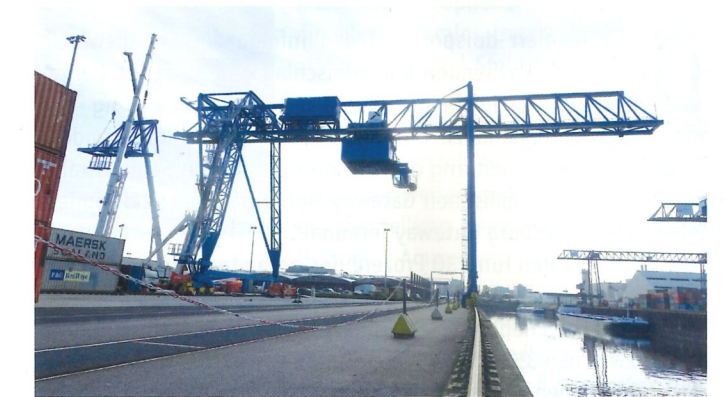
Montage des Auslegers am Terminal Neuss | Bilder: Teichmann
